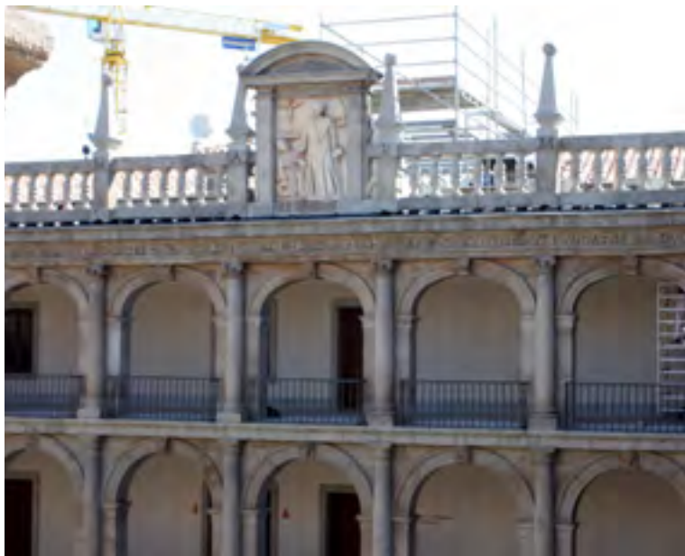
Obras de rehabilitación de la Manzana Fundacional Cisneriana de Alcalá de Henares, en las que se ubica la sede del INAP de Alcalá de Henares
