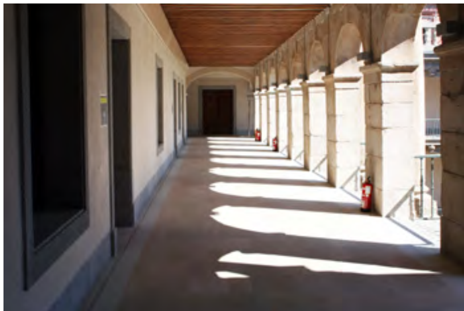
Corredor de la segunda planta del edificio donde se ubican las dependencias del INAP
